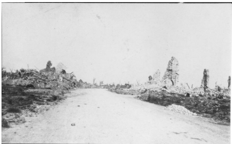
Vieille-Chapelle – L'église est complètement détruite
